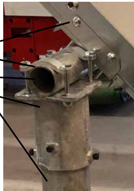
Figur 44: Detalj innfeste av rør og kombifeste/travers.
