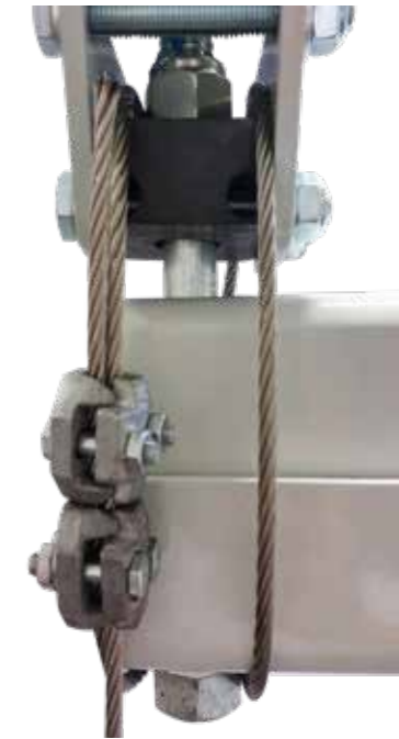
Figur 45: Bakside av oppheng med sikkerhetswire.
