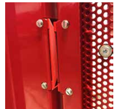
Figur 56: Elektromagnetisk dørbryter
