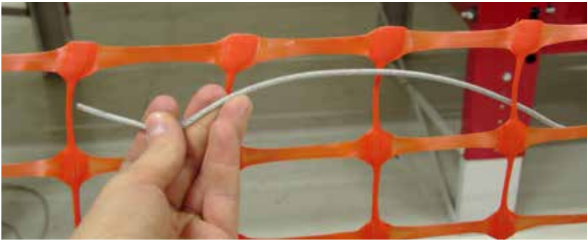
Figur 34: Wire tres inn i sikkerhetsnettet.
