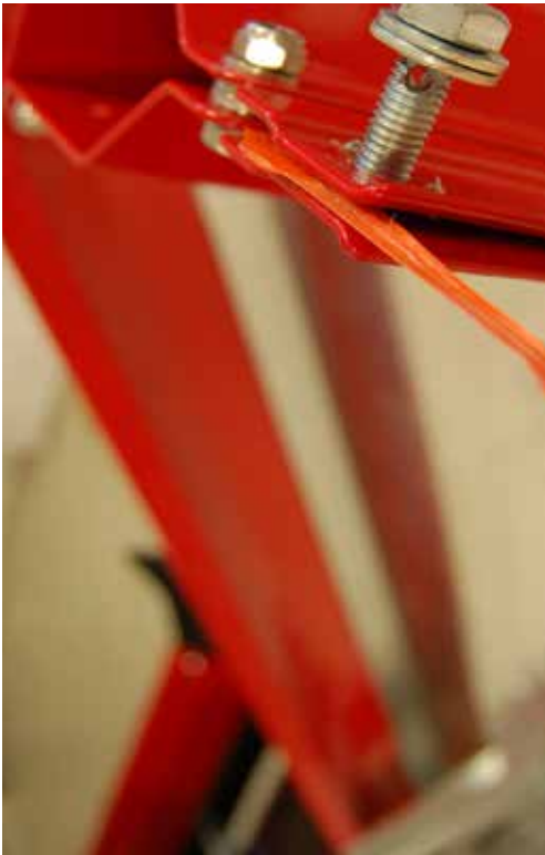
Figur 38: Innsiden av portstolpen. Wiren er trukket rundt wirestaget og festet med wireklemme.
