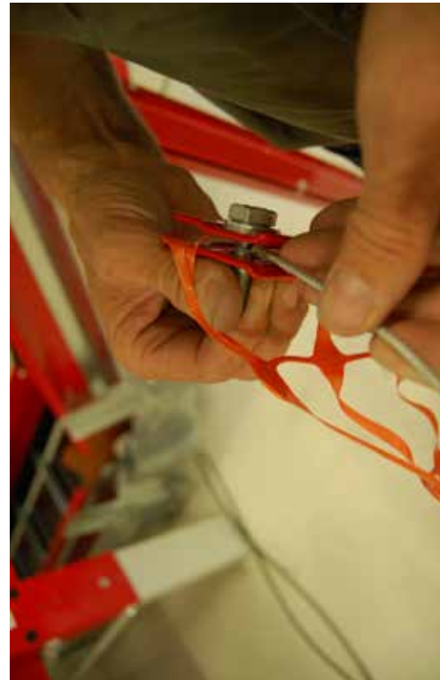
Figur 37: Sikkerhetsnett festet med strips til portstolpen.
