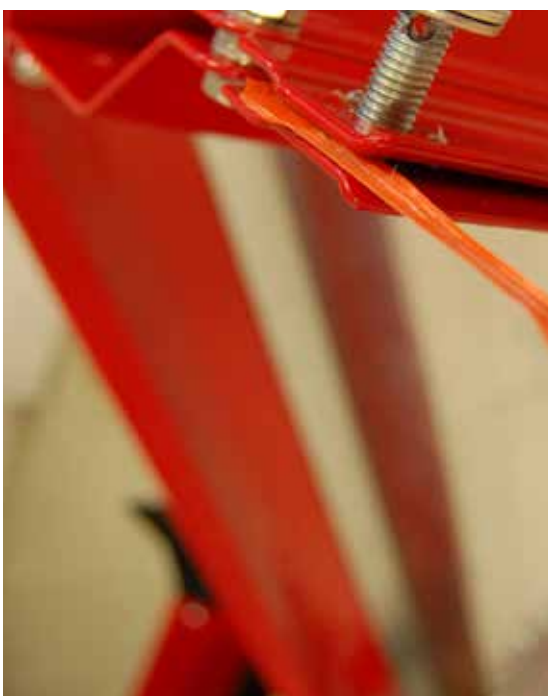
Figur 46: Innsiden av stolpen. Wiren er trukket rundt wirestaget og festet med wireklemme.
