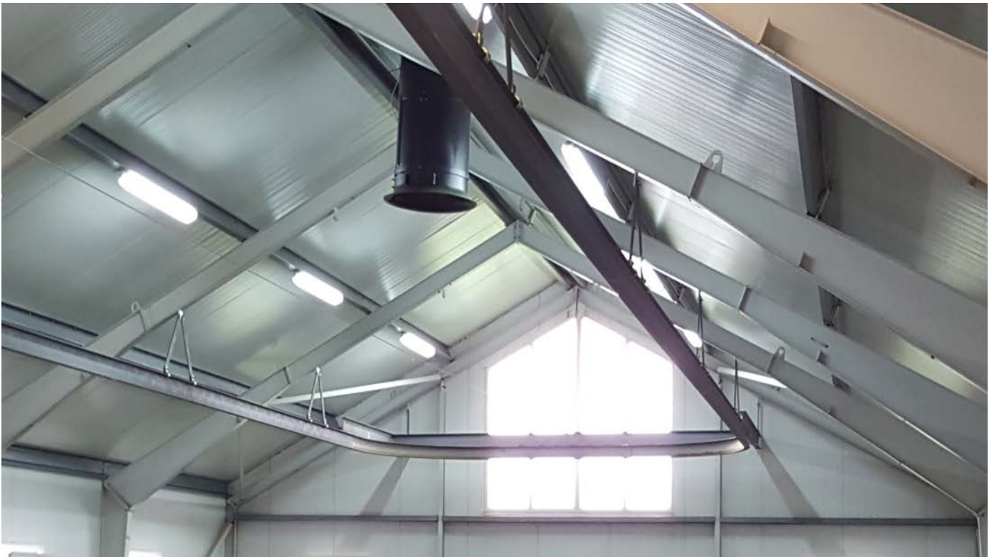
Figur 32 Skinne opphengt i stålsperr med A-oppheng med på sveiste fester. Avstivet i endene og svingene med dubling av IPE-skinnen.
